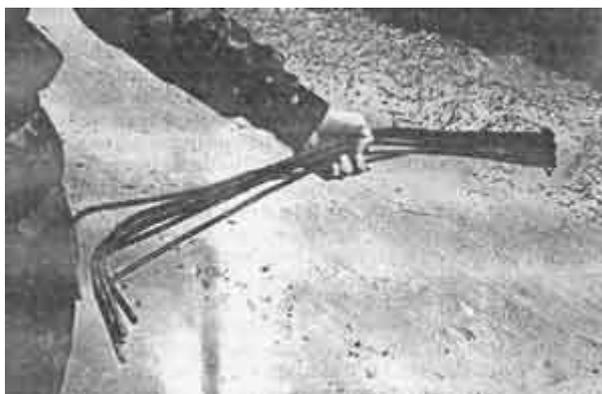
**Фото 775.** Каркас в сложенном состоянии
